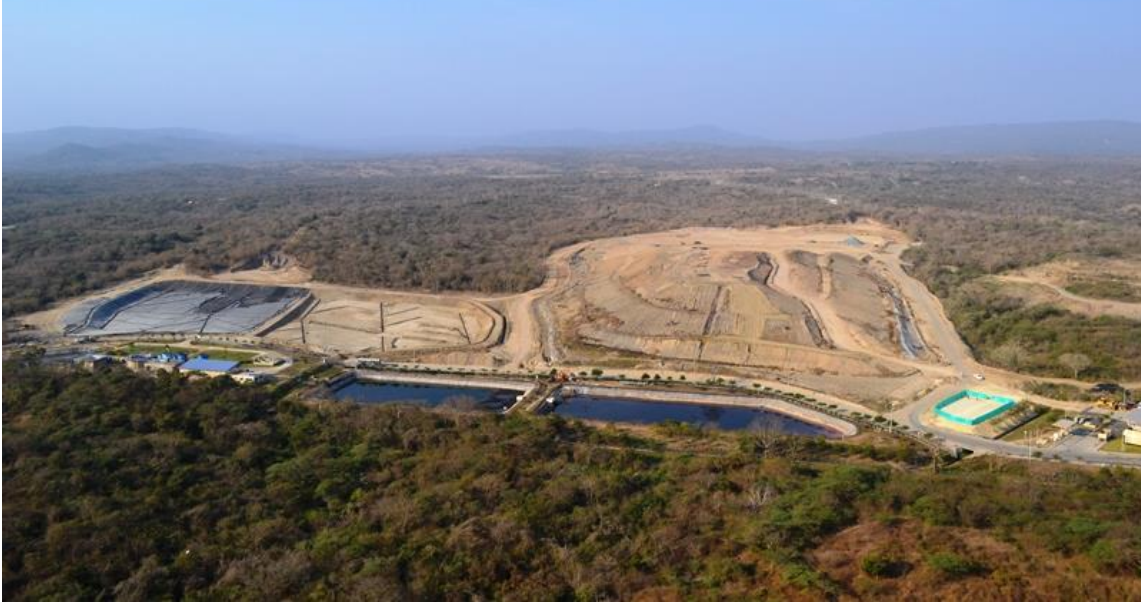
Figura 3.2.7. Relleno Sanitario Los Pocitos localizado a 15 kilómetros de Barranquilla en la vía Barranquilla- Tubará. Fuente: Triple A S.A E.S.P.
