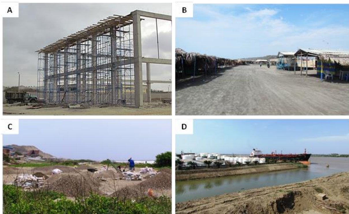
Figura 3.2.1. Actividades en la zona costera del departamento del Atlántico. A) Construcción de bodegas industriales cercanas a la Base Naval, B) Casetas para atención a turistas en Salgar, C) Extracción de material cerca al arroyo Juan de Acosta y D) Sociedad portuaria de Barranquilla en el río Magdalena. Fotografías: Diana Sánchez- INVEMAR.
